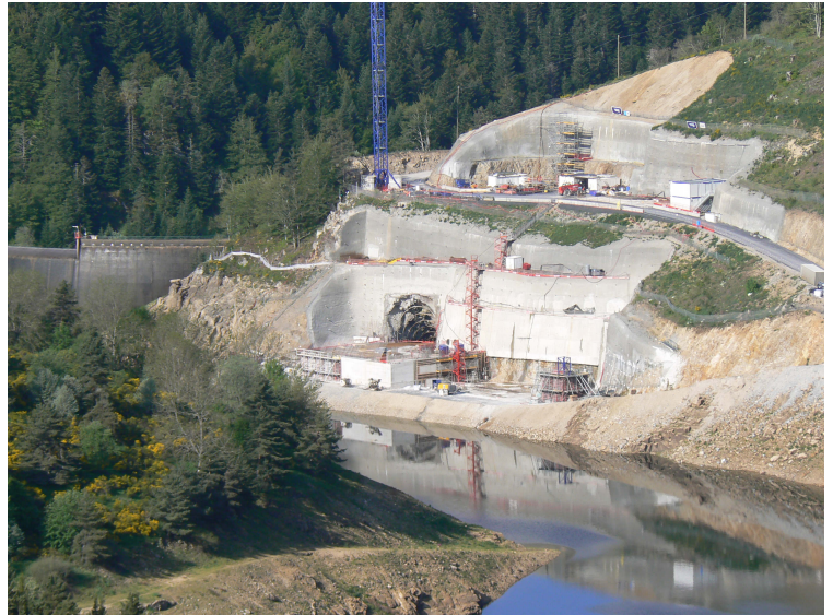
Le barrage du Gage est le théâtre du plus gros chantier en Ardèche actuellement
