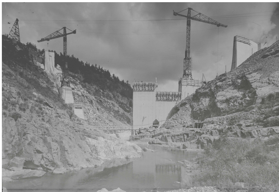
Construction de la voûte de La Palisse autour de 1952
